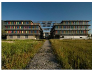
Les locaux de l'Agence Savoie à Technolac au Bourget-du-Lac
